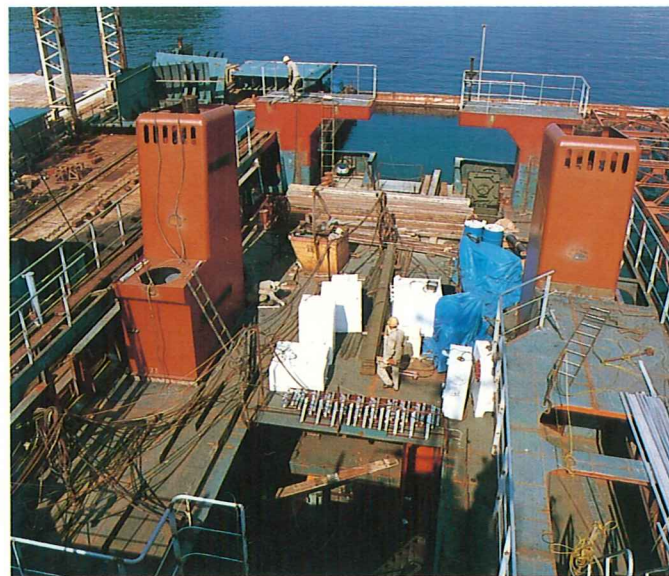
ブロック搭載完了時の艀上甲板
