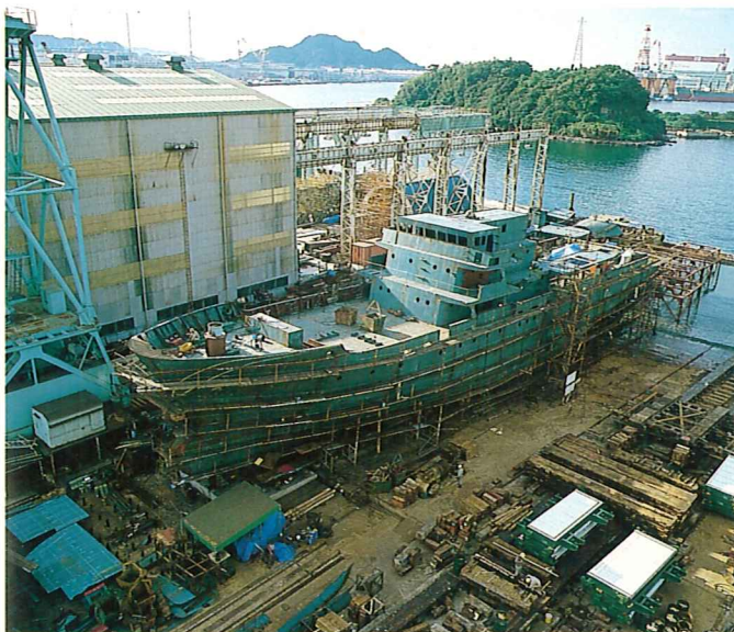
ブロック搭載完了
