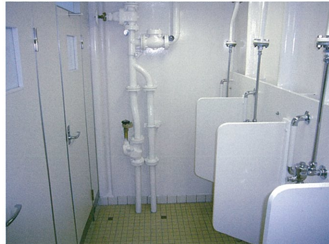
乗組員衛生室 CREW'S SANITARY SPACE
