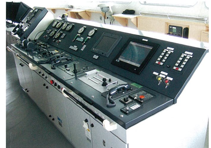
機関制御区画 MACHINERY CONTROL SPACE
