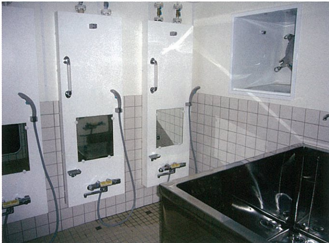
乗組員浴室 CREW'S BATH ROOM
